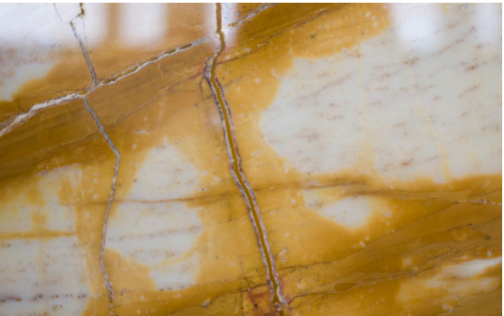
resinatura fessura (dettaglio) - slit resin coating (detail)
