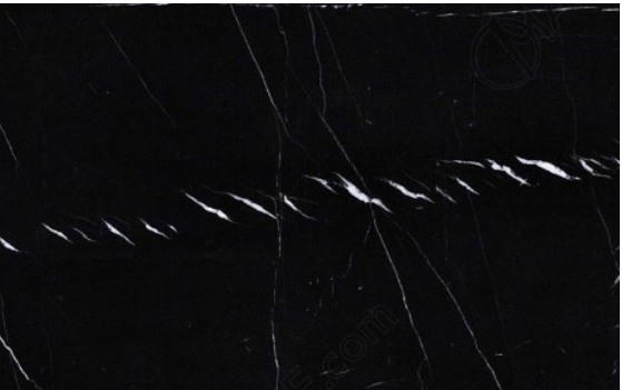
linee di screpolatura (dettaglio) - cracking lines (detail)
